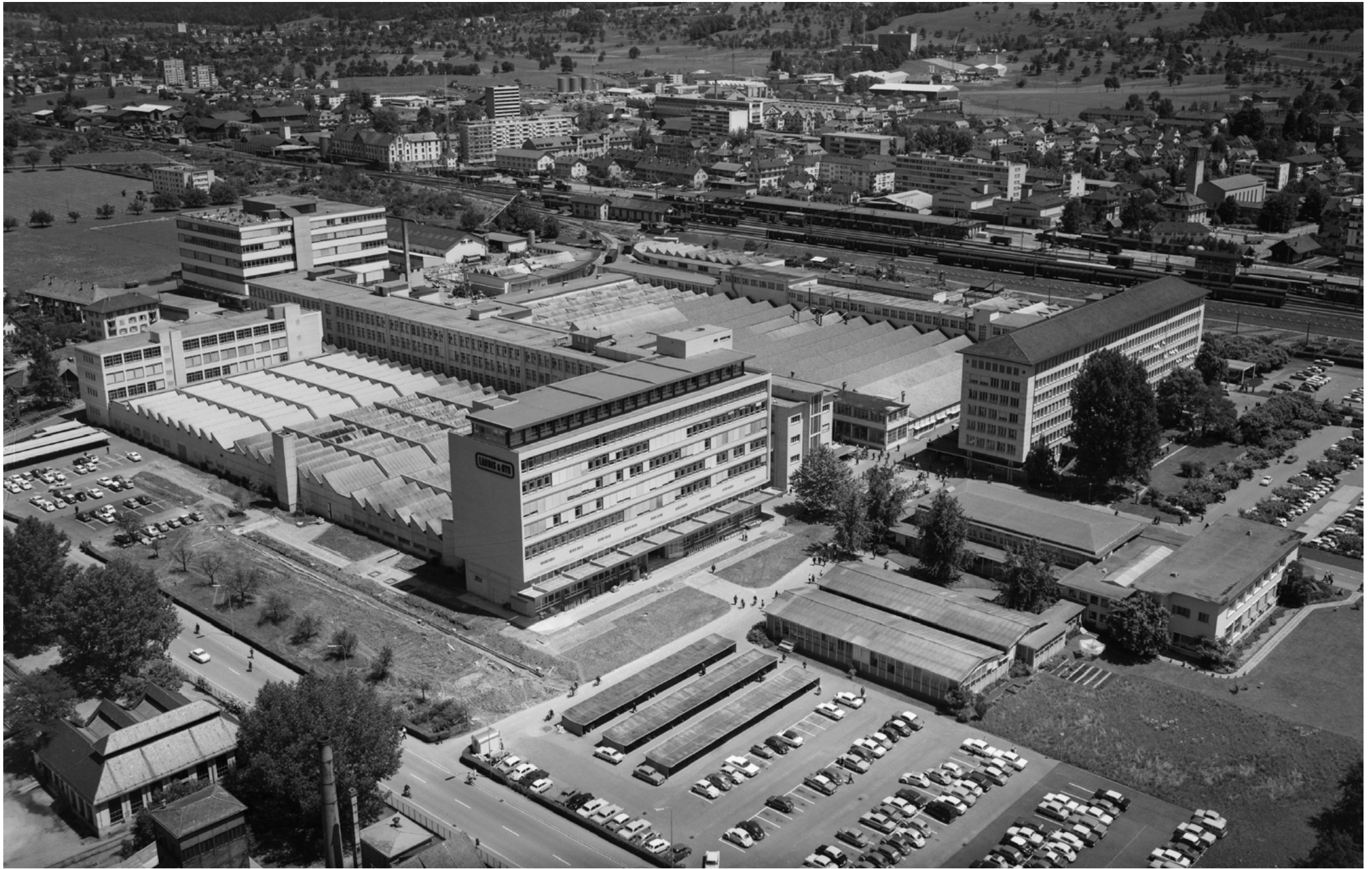
Das Landis & Gyr Areal am 22.6.1966. ETH-Bibliothek Zürich, Bildarchiv / Fotograf: Comet Photo AG (Zürich) / Com_F66-08094 / CC BY-SA 4.0
