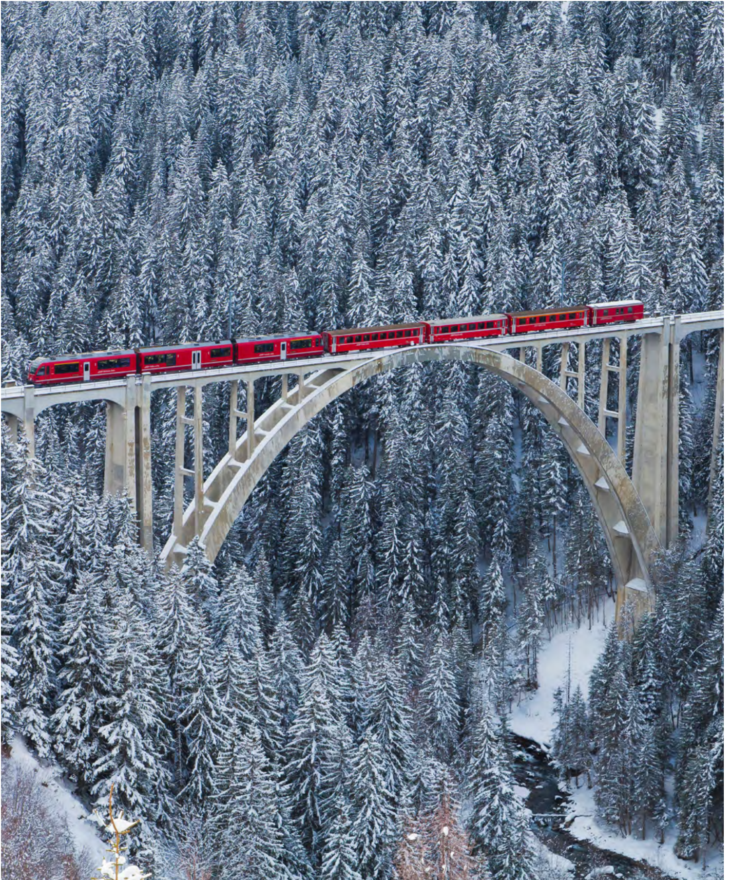
Der 284 Meter lange Langwieser Viadukt auf der Bahnstrecke Chur-Arosa von Hermann Schürch und Karl Arnstein für die Firma Züblin aus dem Jahr 1912. Foto: Werner Dieterich.
