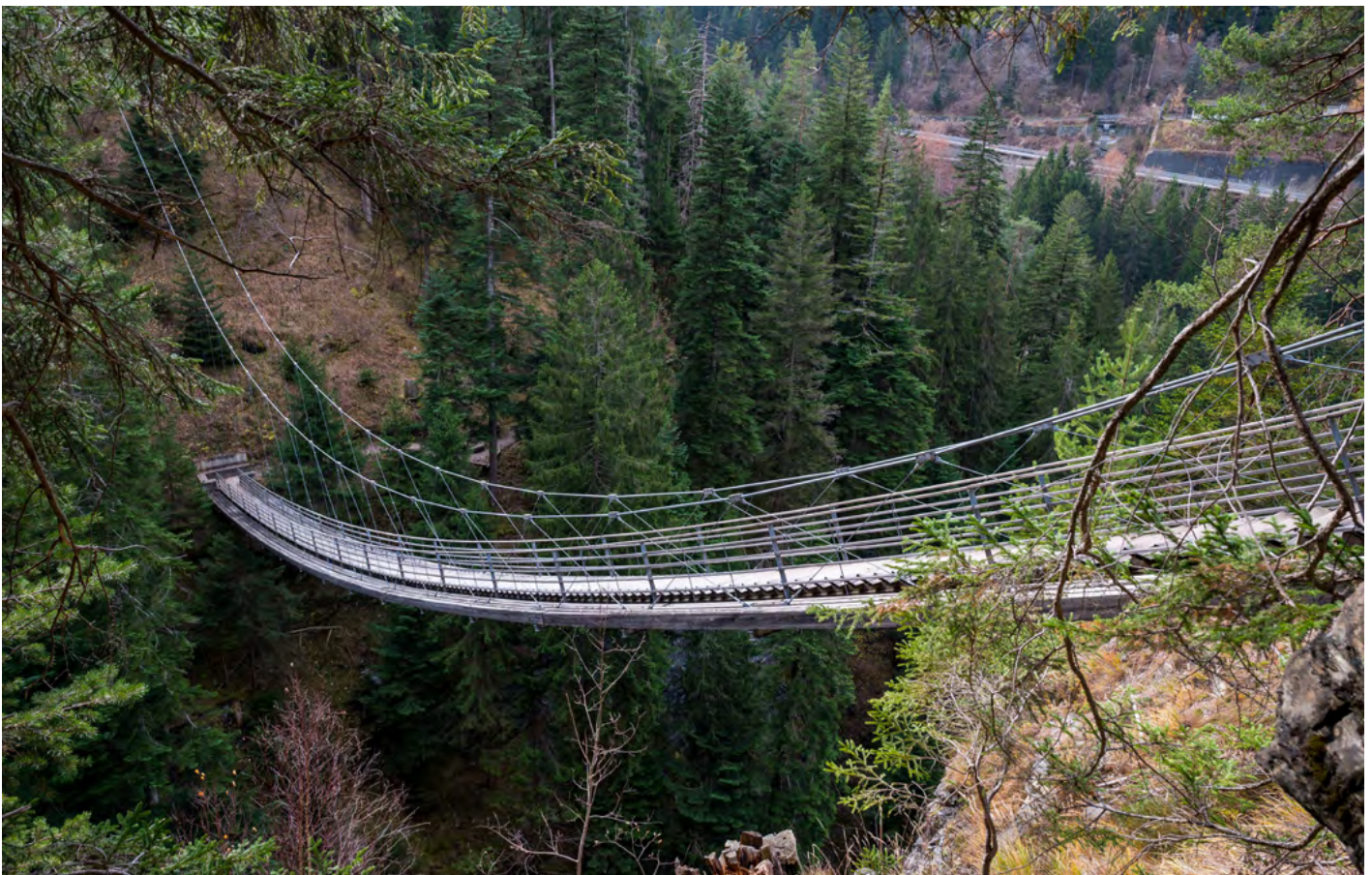
Die Spannweite des Traversinergests von 2005 beträgt 56 Meter, die Seilspannweite 95 Meter. Foto: Marcel Gross.
