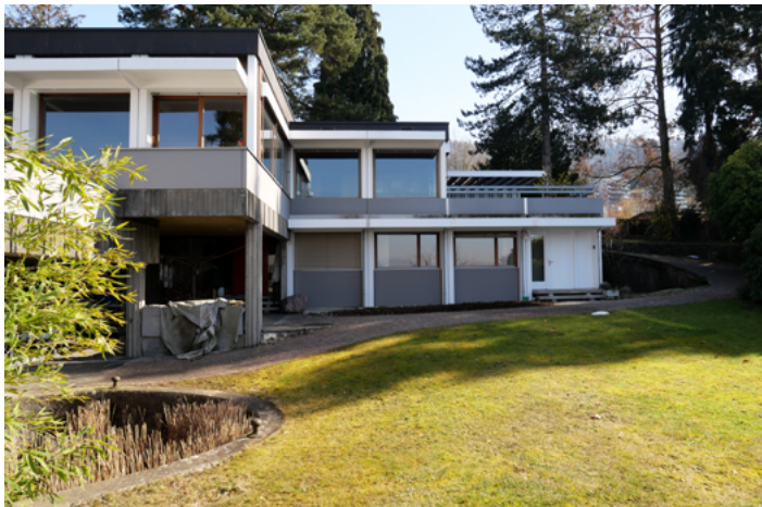
Jedes Fenster zeigt eines der vorgefertigten Raumelemente an, aus denen das Haus zusammengesetzt ist. Foto: Michael Hanak.
