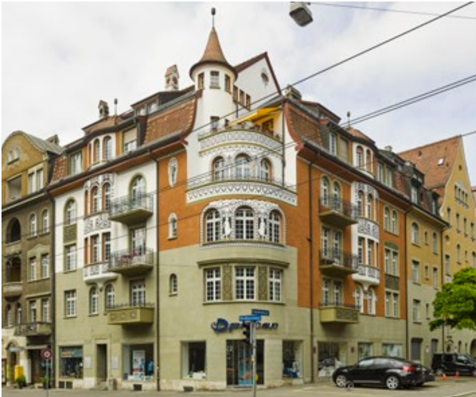
Malerische Rekonstruktion des originalen Fassadenschmucks (Sgraffiti) nach fotografischer Vorlage. Foto: Dominique Uldry.
