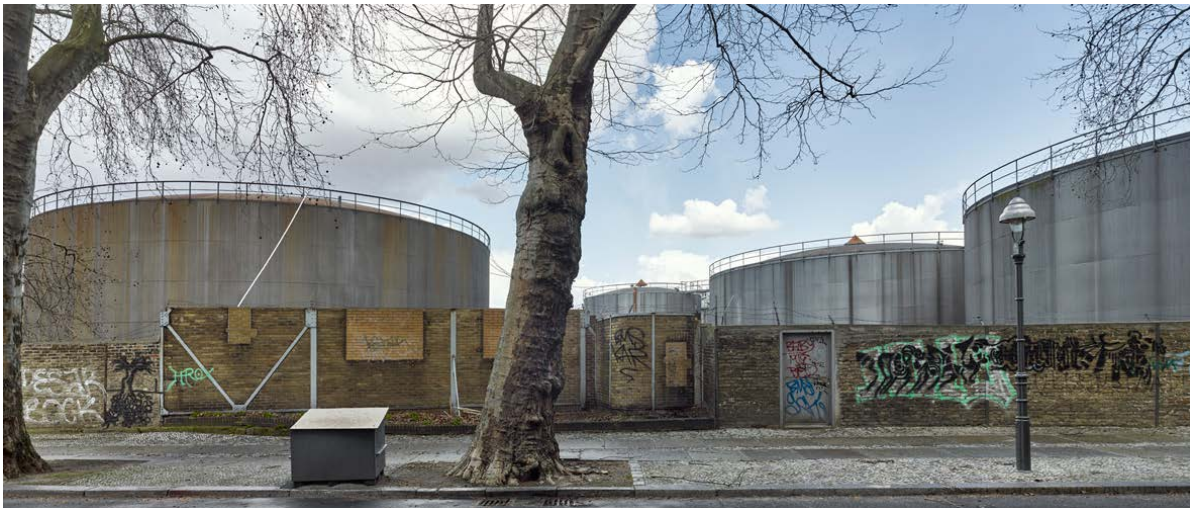
Aktuelle Aufnahmen vom Gelände der zukünftigen WerkBund-Stadt. Am Spreebord. ©WerkBundStadt Berlin.
