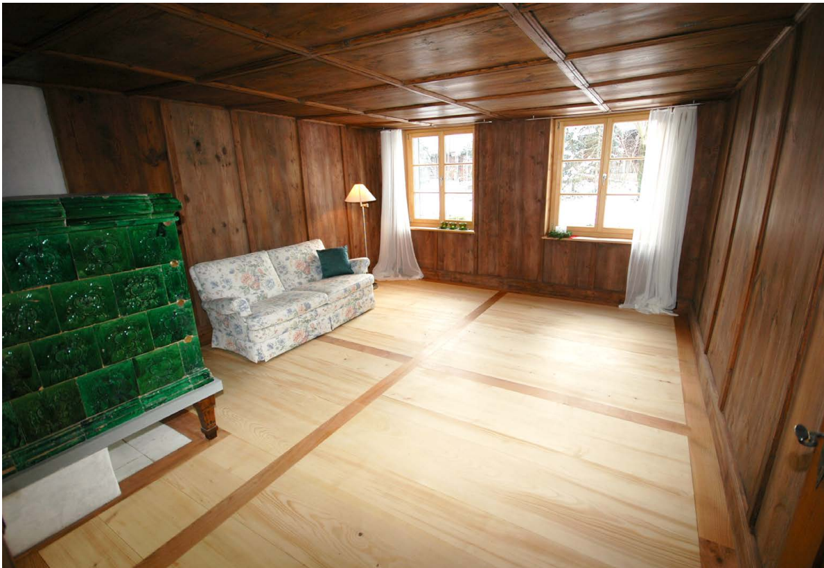
Stube eines Bauernhauses in Frauenfeld, um 1680. Restaurationsarbeiten: Die Holzdecke und Wandtäfer wurden während der Bauzeit demontiert und gereinigt und restauriert wieder eingebaut. Der – der Epoche entsprechende – Felderboden wurde ergänzt. Foto: Hanspeter Strang.
