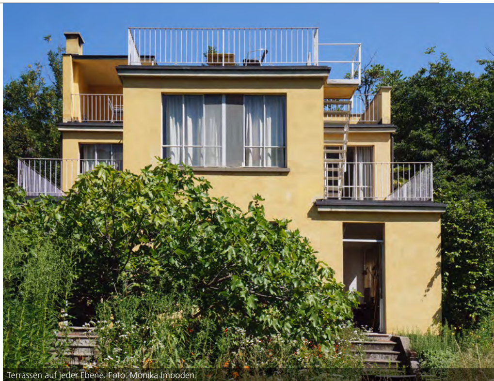
Terrassen auf jeder Ebene. Foto: Monika Imboden.
