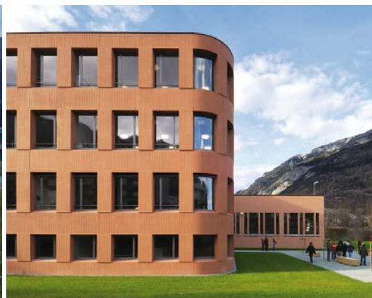
Erweiterung und Umbau Oberstufenschulhaus Giacometti, Chur – A. Christen & C. Drilling. Foto: Ralph Feiner, Malans
