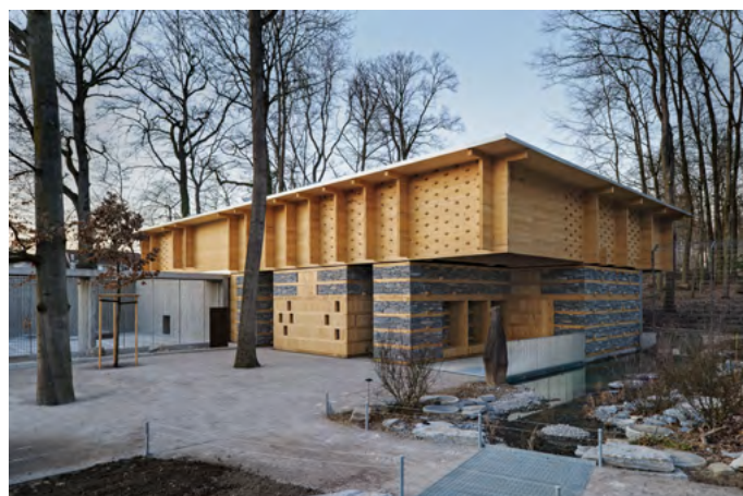
↑ La «Maison des ours» (construite en 2012): construction composite en pierre sèche et bois pour le centre des visiteurs et visiteuses de l'espace des ours dans le parc zoologique Dählhölzli à Berne.
