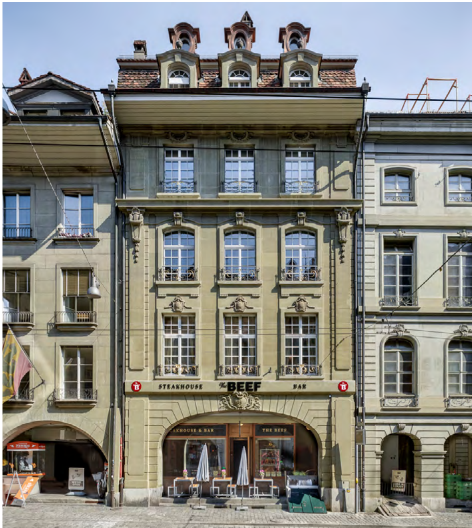
Fassade mit neuen Lukarnen im Steildachbereich an der Kramgasse in Bern. Foto: Alexander Gempeler.
