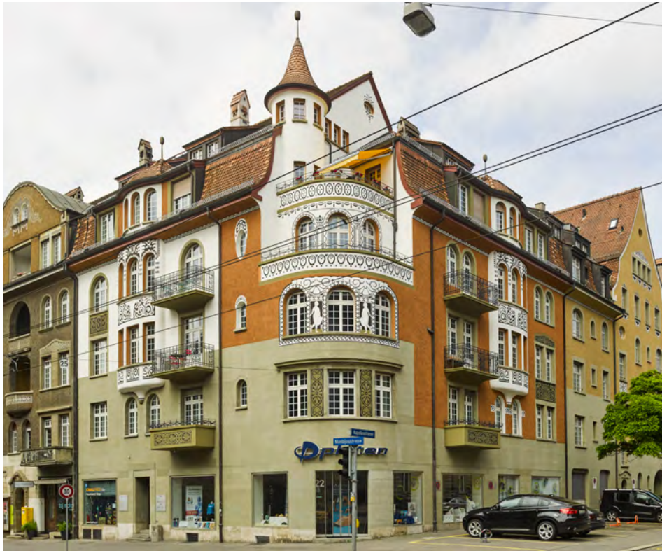
Malerische Rekonstruktion des originalen Fassadenschmucks (Sgraffiti) nach fotografischer Vorlage. Foto: Dominique Uldry.
